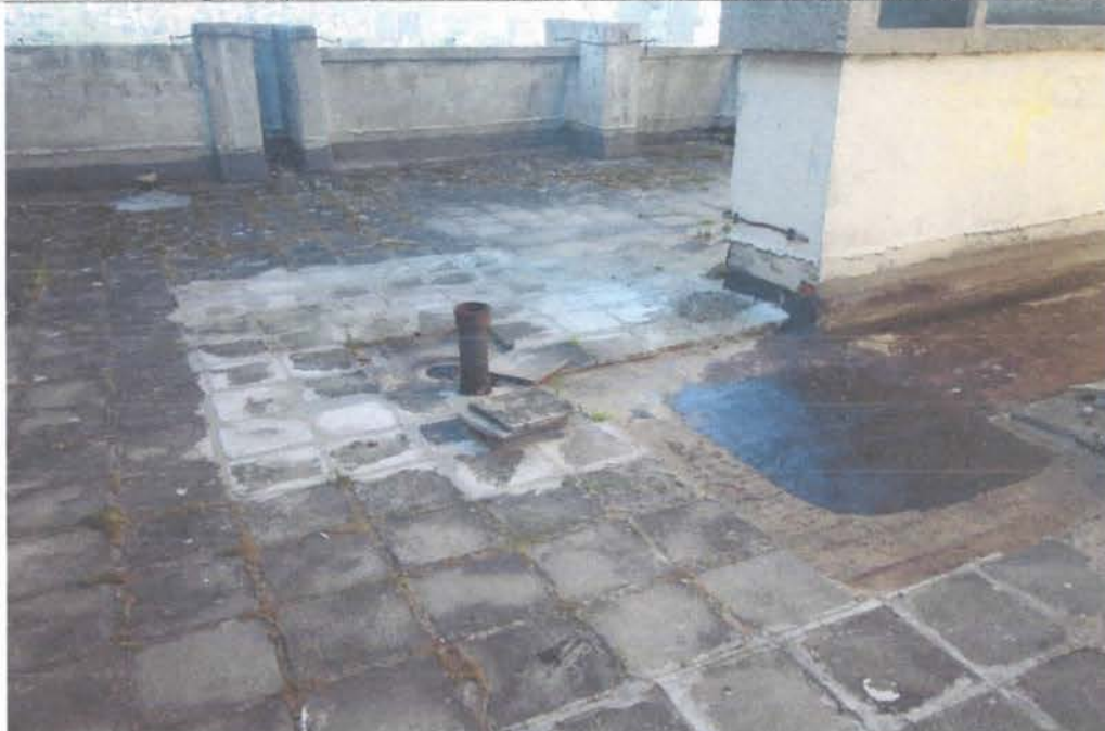
Сл.бр.21. Започети на прекинути санациони радови на кровној површини зграде изнад стана 47
