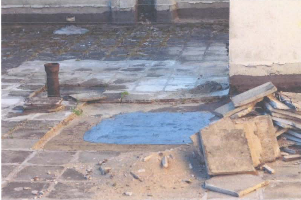
Сл.бр.19. Започети на прекинати санациони радови на кровној површини зграде изнад стана 47
