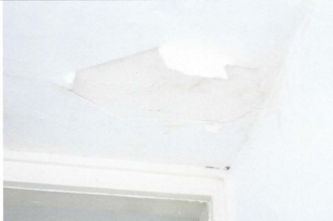
Сл.бр.17. Флека на плафону у кухињи, поред „Техничког канала“, за вентилацију.
