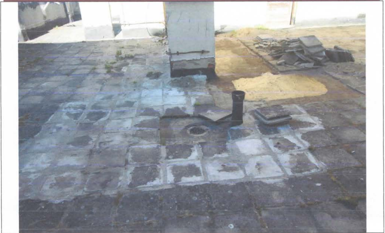
Сл.бр.22. Започети на прекинута санациони радови на кровној површини зграде изнад стана 47
