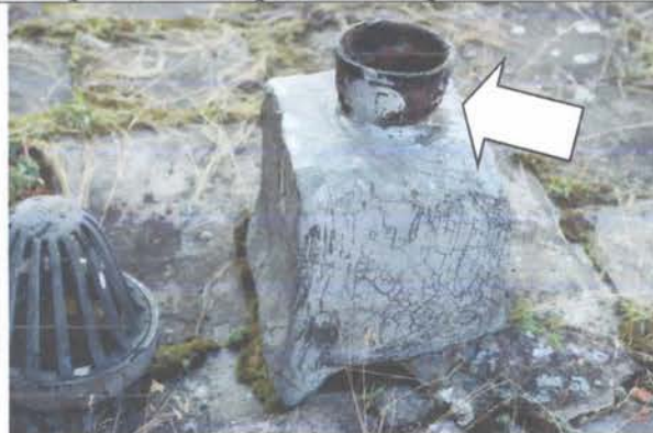
Сл.бр.38. Сливник за прихват кишнице и стрелицом обележен ваздушни одушак за канализациону цев санитарне отпадне воде.
